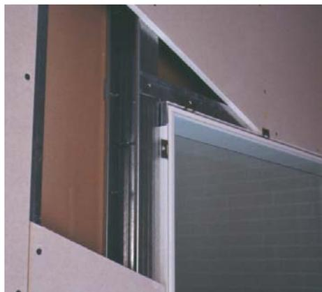
Per l'installazione di una finestra, di una vetrata, di un lucernario, con il Sistema Knauf KV® non è richiesto nessun ulteriore intervento di adattamento, neppure di foratura. Nel kit sono presenti tutti gli accessori necessari alla realizzazione: tra questi, conviene ricordare il telaio di rivestimento che ha un'altezza variabile. Le componenti possono inoltre essere smontate per consentire un
